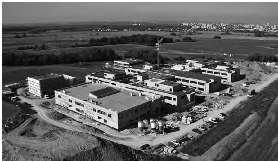
Stavba BIOCEVu, Vestec u Prahy
