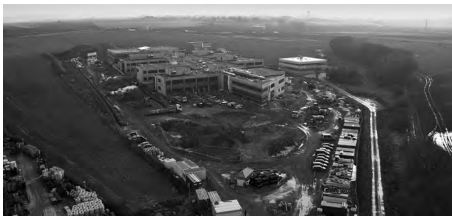
Stavba BIOCEVu ve Vestci u Prahy (2)
